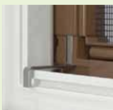
Staffa a "Z" in appoggio. Sistema di sospensione senza fori.
